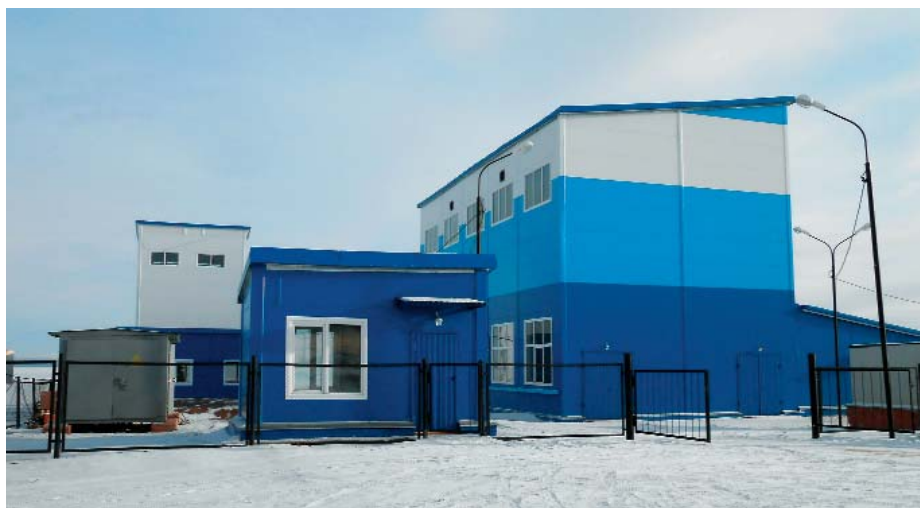
Канализационные очистные сооружения (общий вид)
